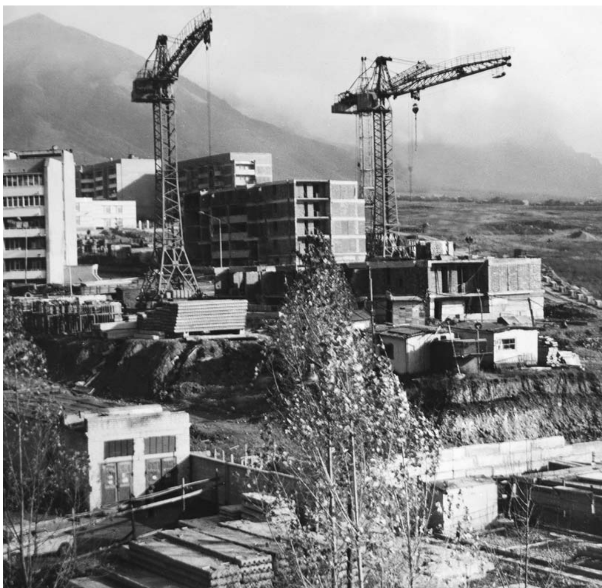
Подгорный район строительства жилья г. Лермонтова, на заднем плане гора Бештау
