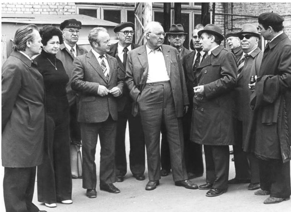
На строительстве объекта гидрометаллургического завода
