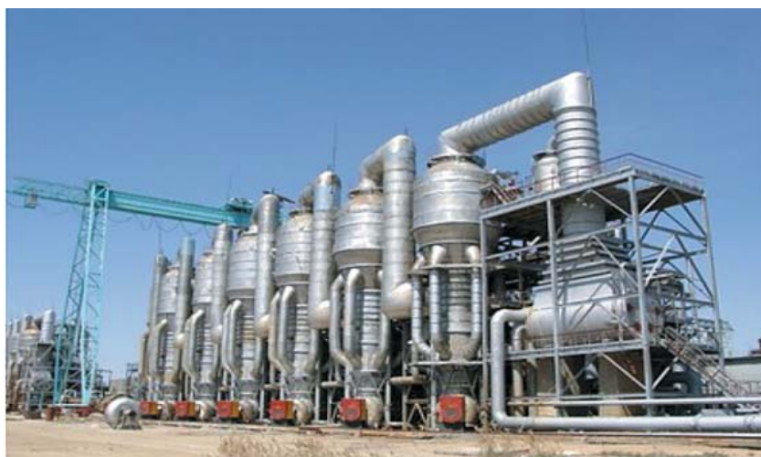
Рис. 4. 10-ступенчатая ДОУ производительностью 600 м 3 /ч
