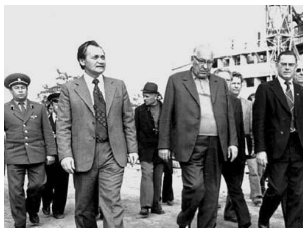
Осмотр строящихся объектов на ЛГХР. На снимке: Э.М. Насибулин, В.В. Кротков, Е.П. Славский, А.В. Нещерет
