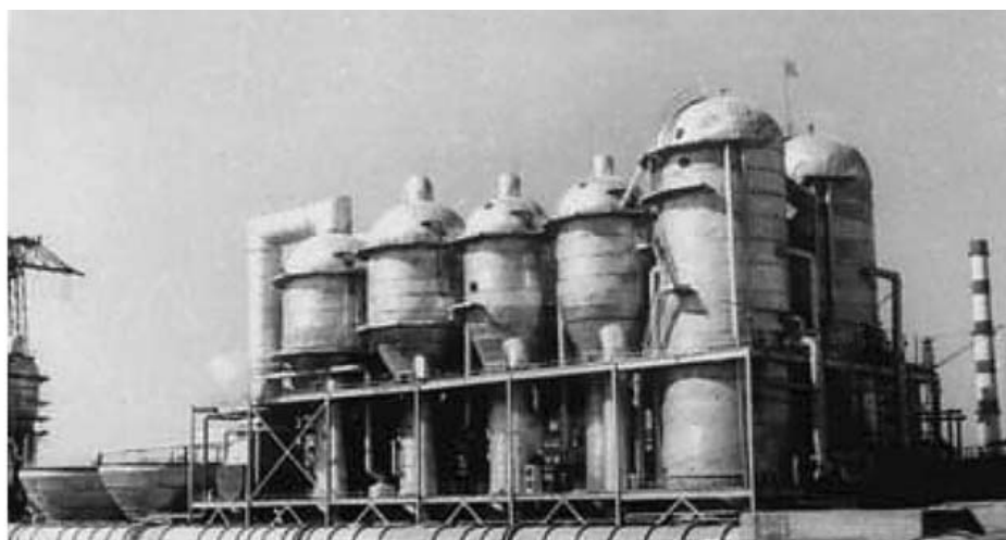
Рис. 3. Две опреснительные установки первого блока ЗПД производительностью по 600 м 3 /ч каждая
