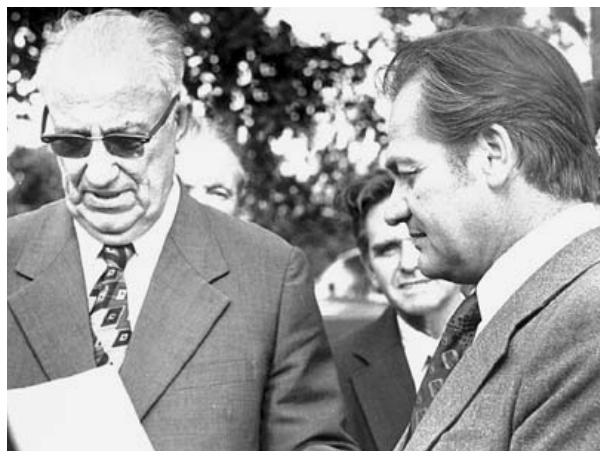
Обсуждение с В.В. Киреевым ход выполнения строительно-монтажных работ согласно титульному списку капстроительства ЛГХР
