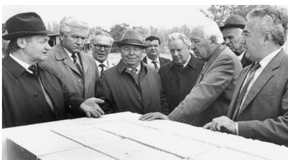
На переднем плане: В.В. Кротков, Н.Б. Карпов, Е.П. Славский и В.И. Химченко обсуждают строительные блоки на основе вяжущего гипса из отходов производства минеральных удобрений
