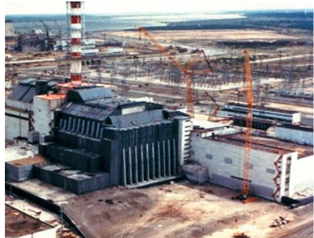
Все готово к сдаче в эксплуатацию объекта «Укрытие»
