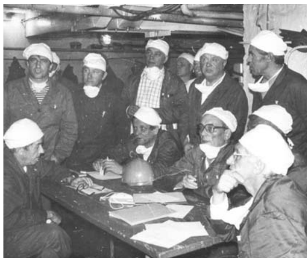
Руководство в «бункере» по телевидению наблюдает за ходом монтажа «Укрытия».
