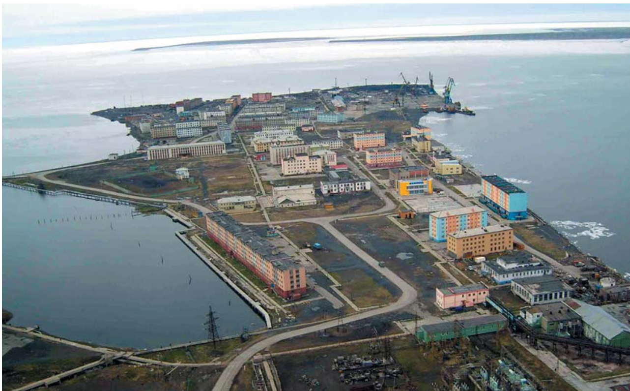
АО «Эльконский ГМК» построит инженерные сети в самом северном городе России — г. Певеке (Чукотский АО)
