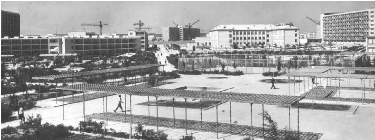
Строительство г. Шевченко
