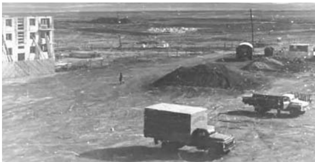
С этого дома начиналось строительство города. Дом № 102. 1967 г.
