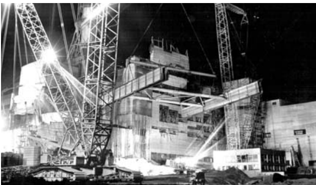
Подъем балки Б-2 («Самолета»)
