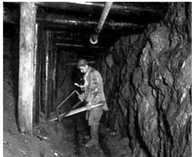
Рудник Вайсер Хирш. Крепильщик устанавливает крепь
