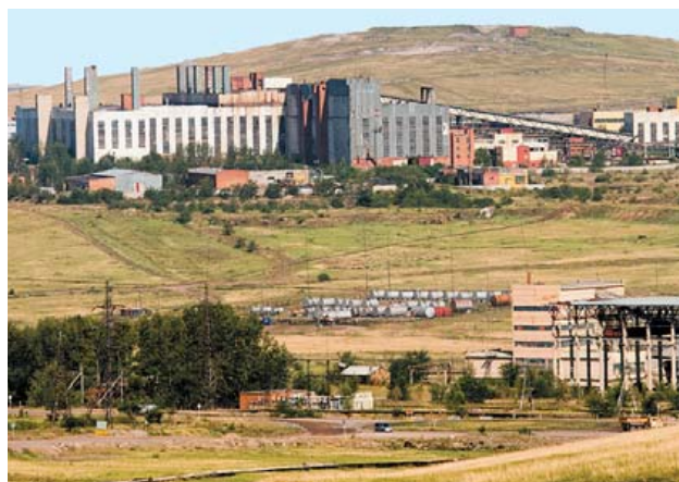
Гидрометаллургический завод ППГХО
