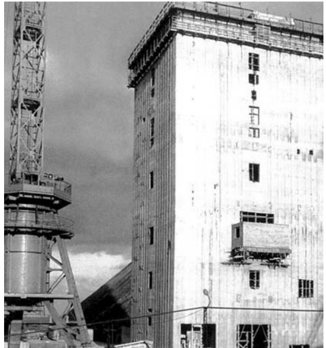
Строительство поверхностного комплекса шахты «Новая Глубокая» с башенным копром
