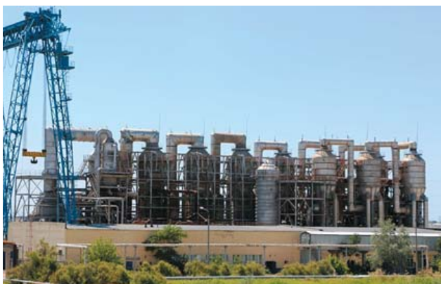
Опреснительный комплекс в г. Актау
