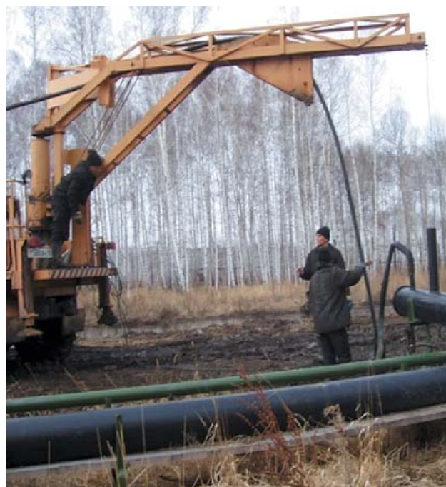
Монтаж электропогружного агрегата установкой «Лебедь»
