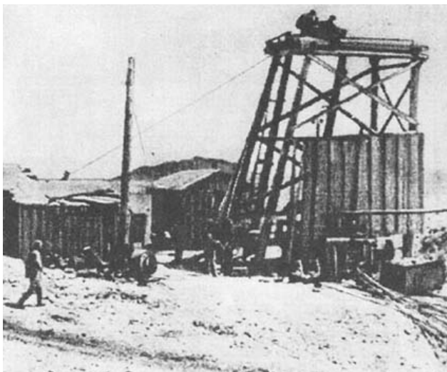
Конструкция копра
