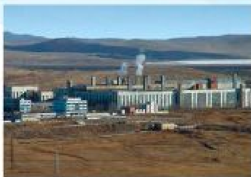
Гидрометаллургический завод по переработке урано-молибденовых руд
