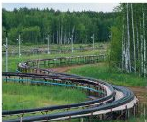
Трубопровод выщелачивающих растворов, смонтированный по спланированной поверхности земли. Заканная скважина, оборудованная герметичным оголовком
