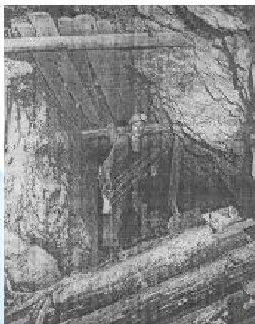
Подготовительные работы в забое
