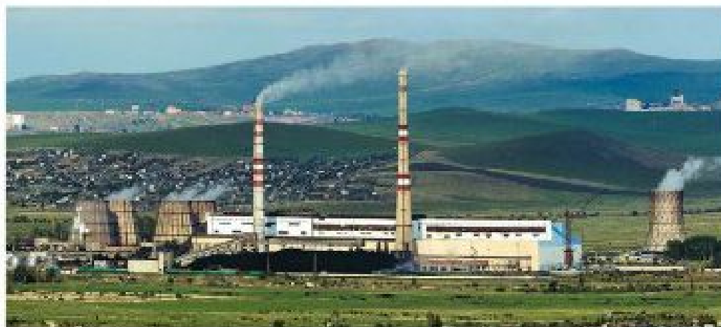
Установленная мощность ТЭЦ составляет 410 МВт (фактическая 285 МВт)
