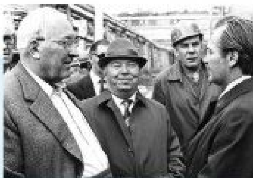
На строительной площадке Е.П. Славский, Н.В. Карпов, В.В. Кротков и др.
