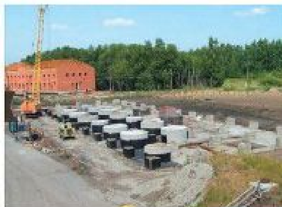
Закладка фундаментов под главный корпус
