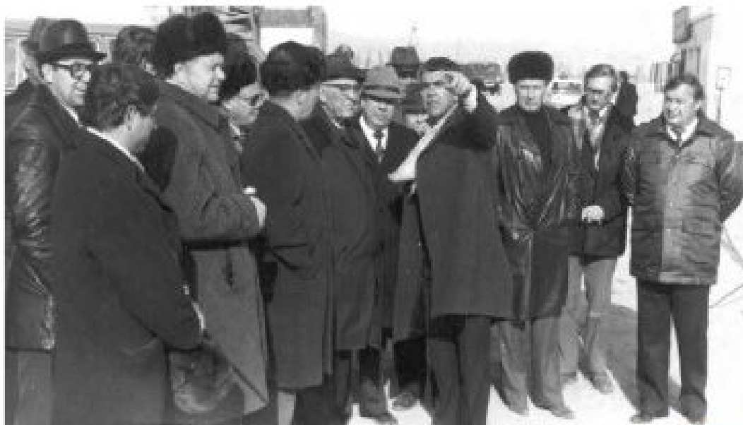
Начальник Навоийского управления строительства Саватоний Геннадий Борисович докладывает министру Е.П. Славскому о ходе строительства объектов в Учкудуке.
