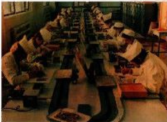
Цех 9. Участок сборки и монтажа электронных блоков
