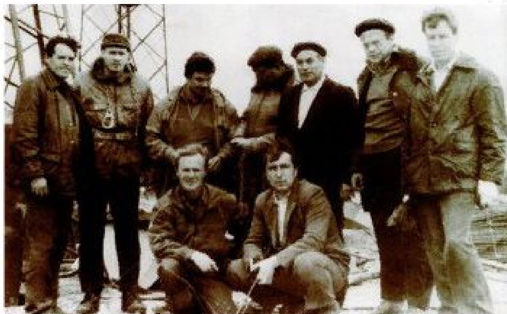
Сотрудники ОКСа на строительном объекте
