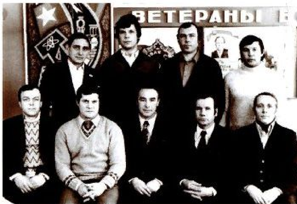
Цех №80. Бригада электриков
