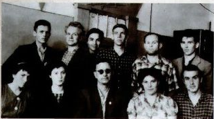
Цех №4. Первые работники цеха
