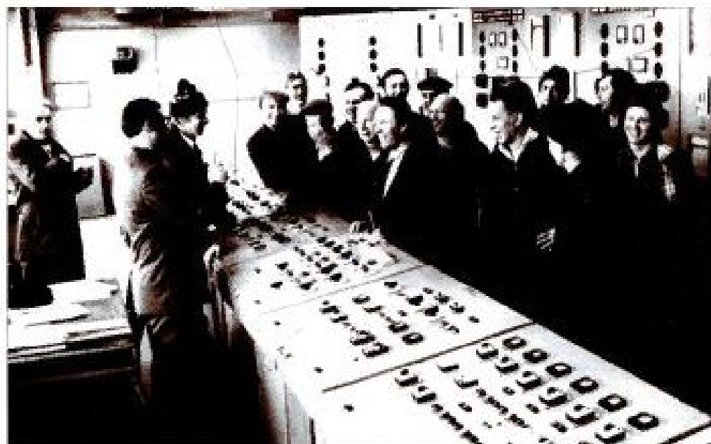
Цех № 12. Пуск котельной
