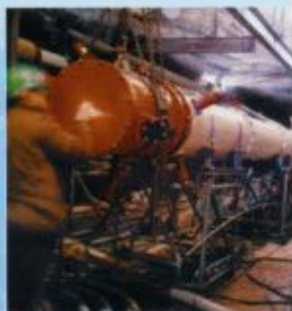
Сборка оборудования в цехе
