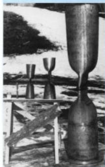
Перекрытие взрывом трубопровода калибром от 20 до 424 мм
