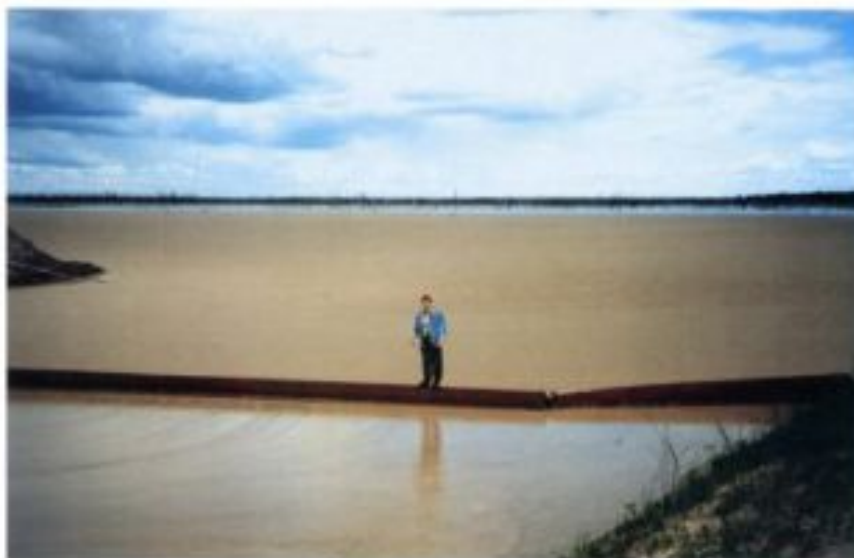
Залотвал Череповецкой ГРЭС
