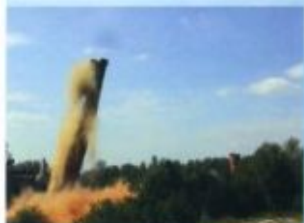
Взрывной демонтаж аварийной трубы ТЭЦ высотой 30 м. Разрушенный объект направленно падает без ущерба для расположенных вблизи производственных помещений и коммуникаций
