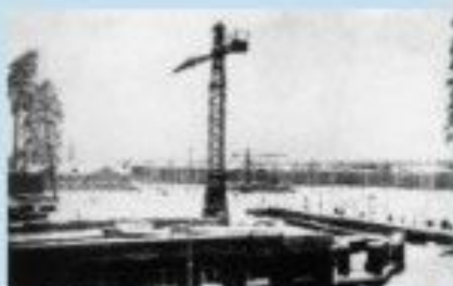
Начало строительства объекта
