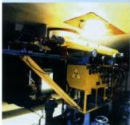
Установка ЛУНА-2М под активной зоной реактора ВИР-2М
