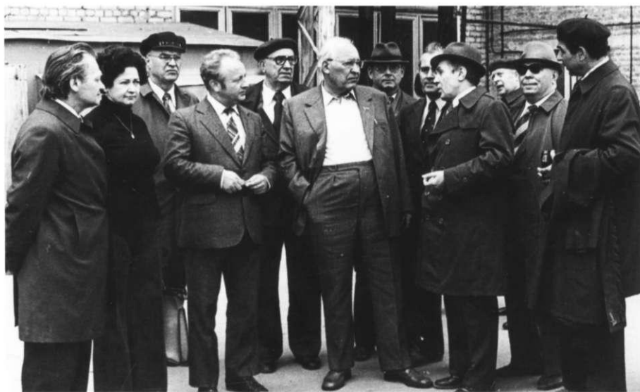
На строительстве объекта гидрометаллургического завода, г. Лермонтов
