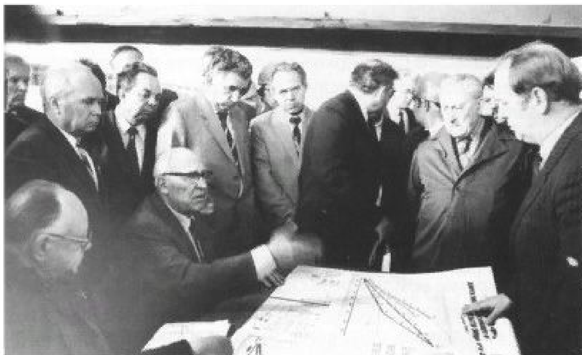
Обсуждение графика строительства завода РТ-2 для переработки топлива АЭС, г. Железногорск, 1973 г.
