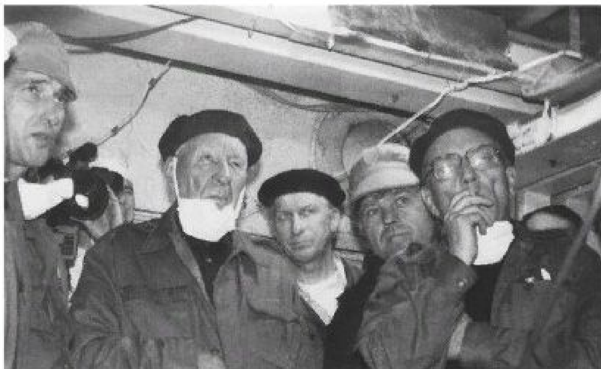
Е. П. Славский, В. С. Андрианов и А. Н. Усанов из «бункера» наблюдают за монтажом «Укрытия» на ЧАЭС, июль 1986 г.
