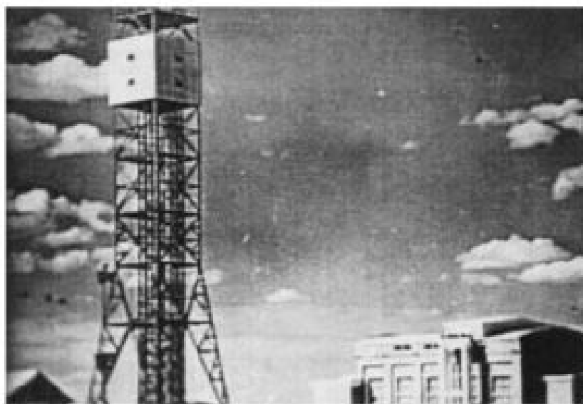
Вышка для установки ядерного заряда на Семипалатинском полигоне
