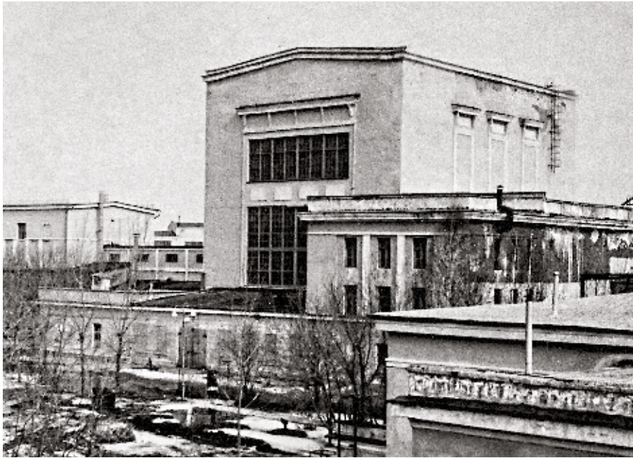
Общий вид здания реактора «А». 1950-е Центратомархив. Ф. 1. Оп. 38с. Д. 22. Л. 116
