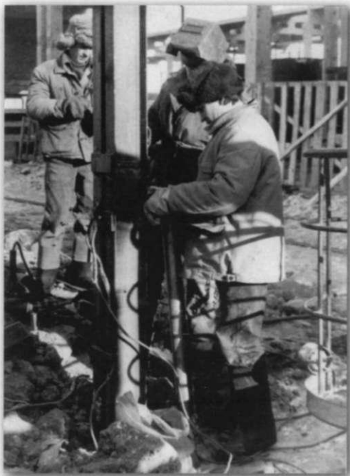
Монтаж оборудования I очереди ТЭЦ, 1972 г.
