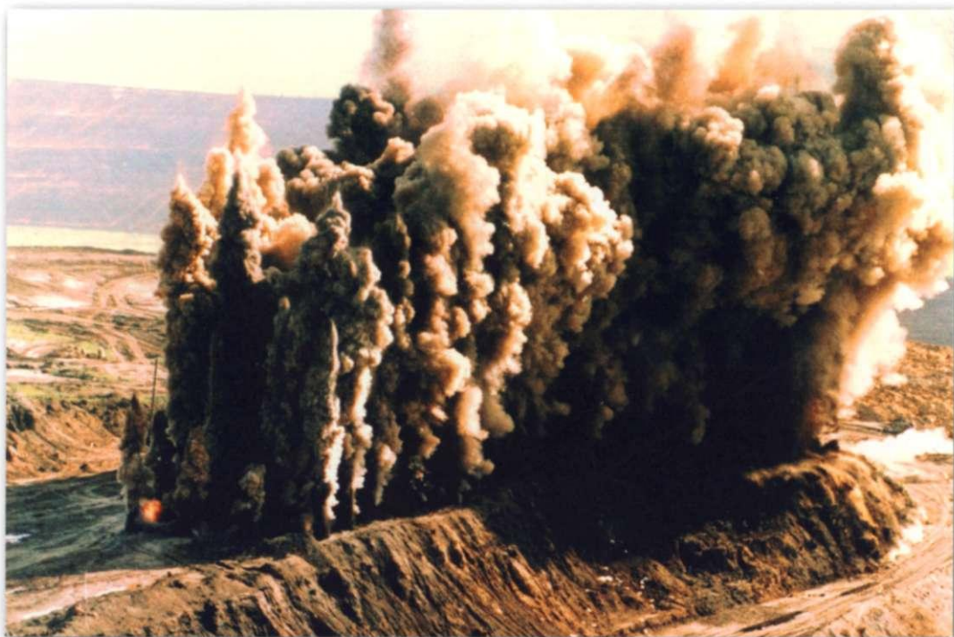
Взрывные работы на Ургуе
