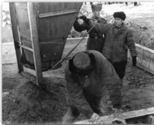
Первая бадья в фундамент РПК, 28 января 1972 г.
