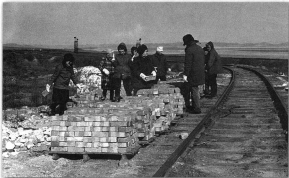
На «БАМЕ». Работы по укладке футеровочного кирпича. 1978 г.
