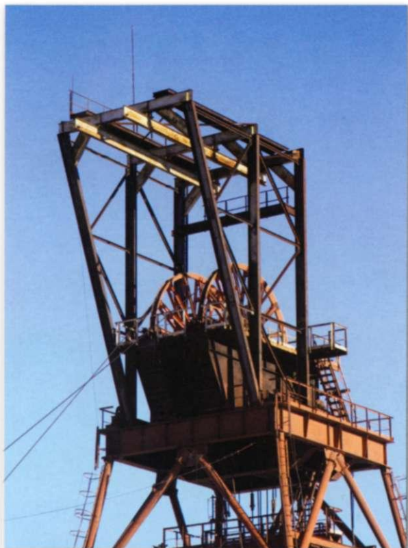
Подшивная площадка копра «Север-1» ствола 12В рудника «Глубокий»
