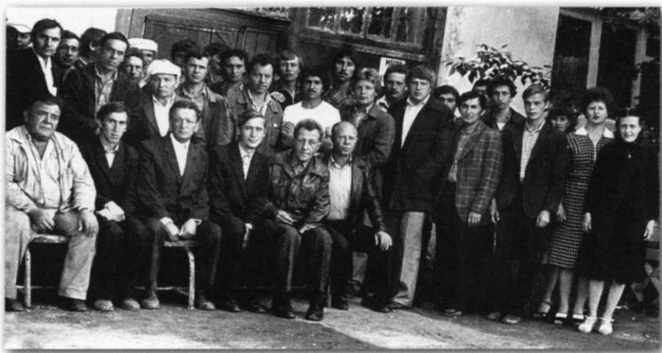
Коллектив цеха сетей и подстанций. 1973 г.
