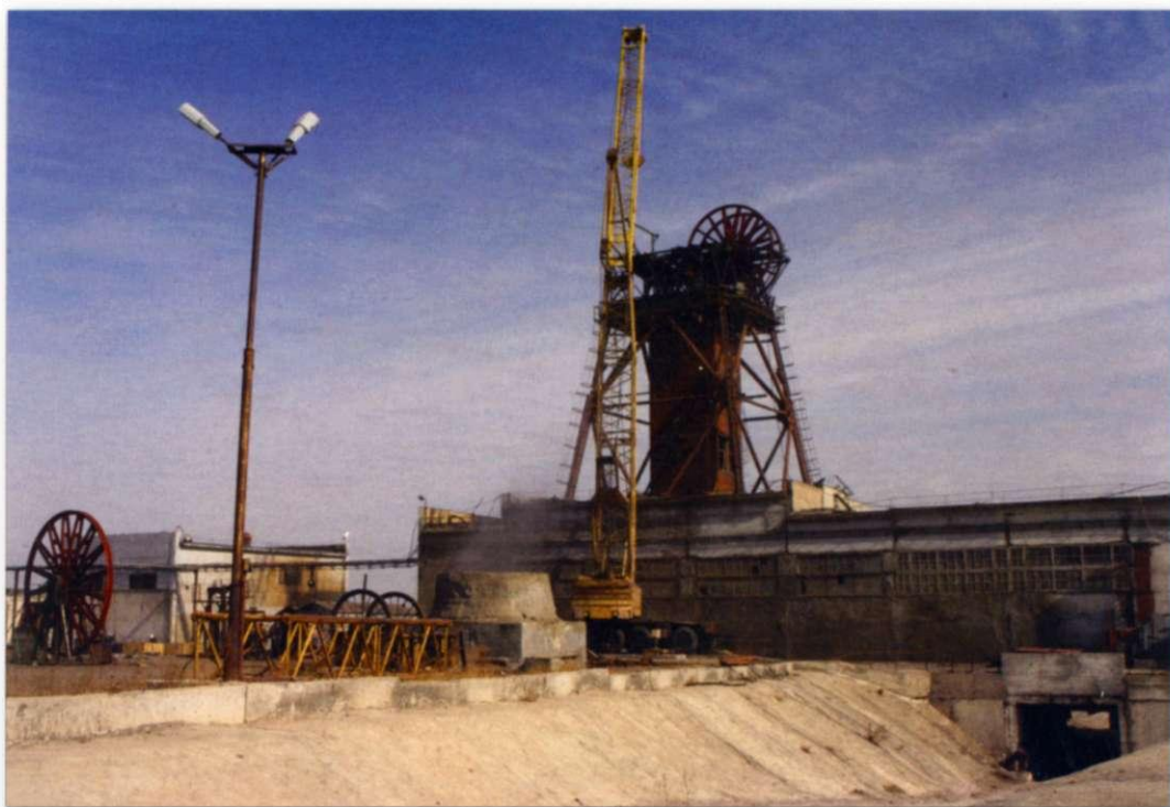
Надшахтный комплекс ствола 5В рудника «Глубокий»
