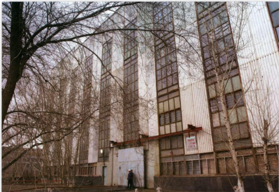
Главный корпус ГМЗ
