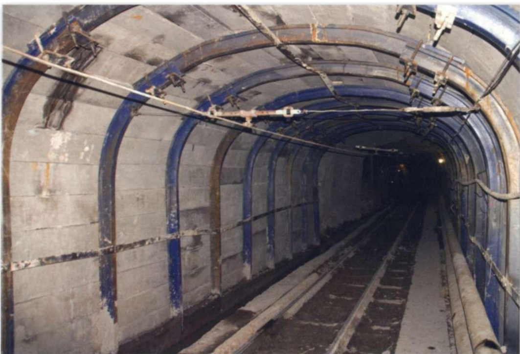
Горизонтальная горно-капитальная выработка
