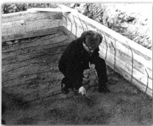
Закладка памятной пластины в первый фундамент завода
