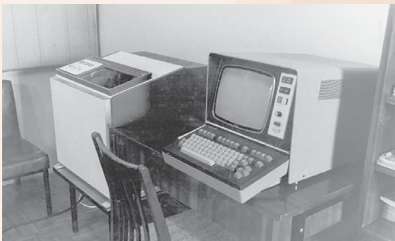
Диалог пользователя с автоматизированной информационно-поисковой системой осуществлялся с помощью устройства «Видеотон-340»
