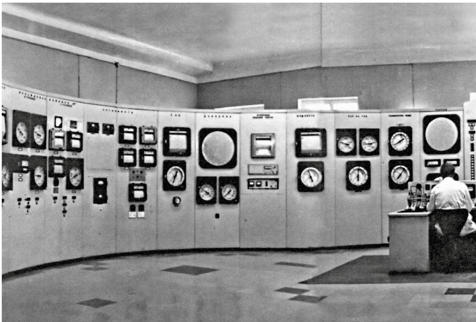
Центральный пульт управления Первой атомной электростанцией. 1950-е
