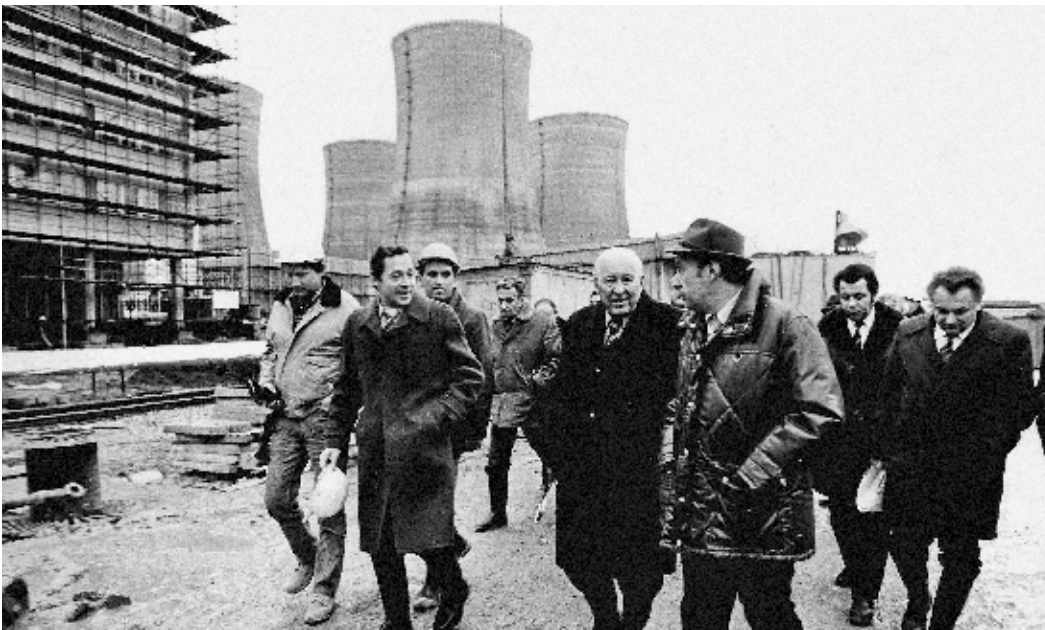
На строительной площадке атомной электростанции «Дукованы». Чехословакия. 17 декабря 1982 года Музей истории города Обнинска
