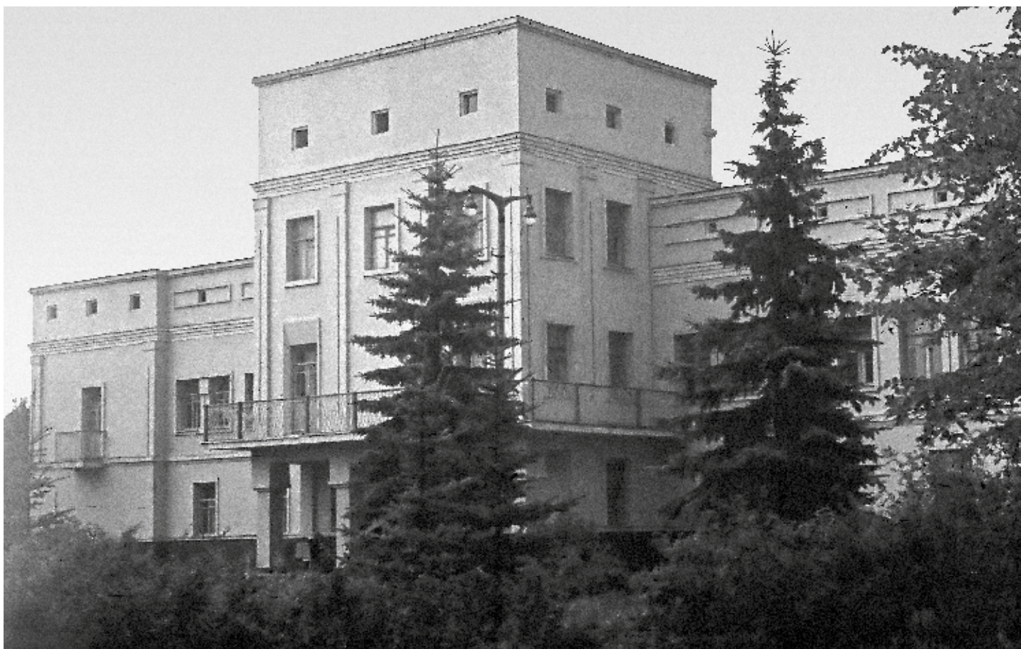
Главный корпус дома отдыха Министерства среднего машиностроения «Опалиха». 1973
