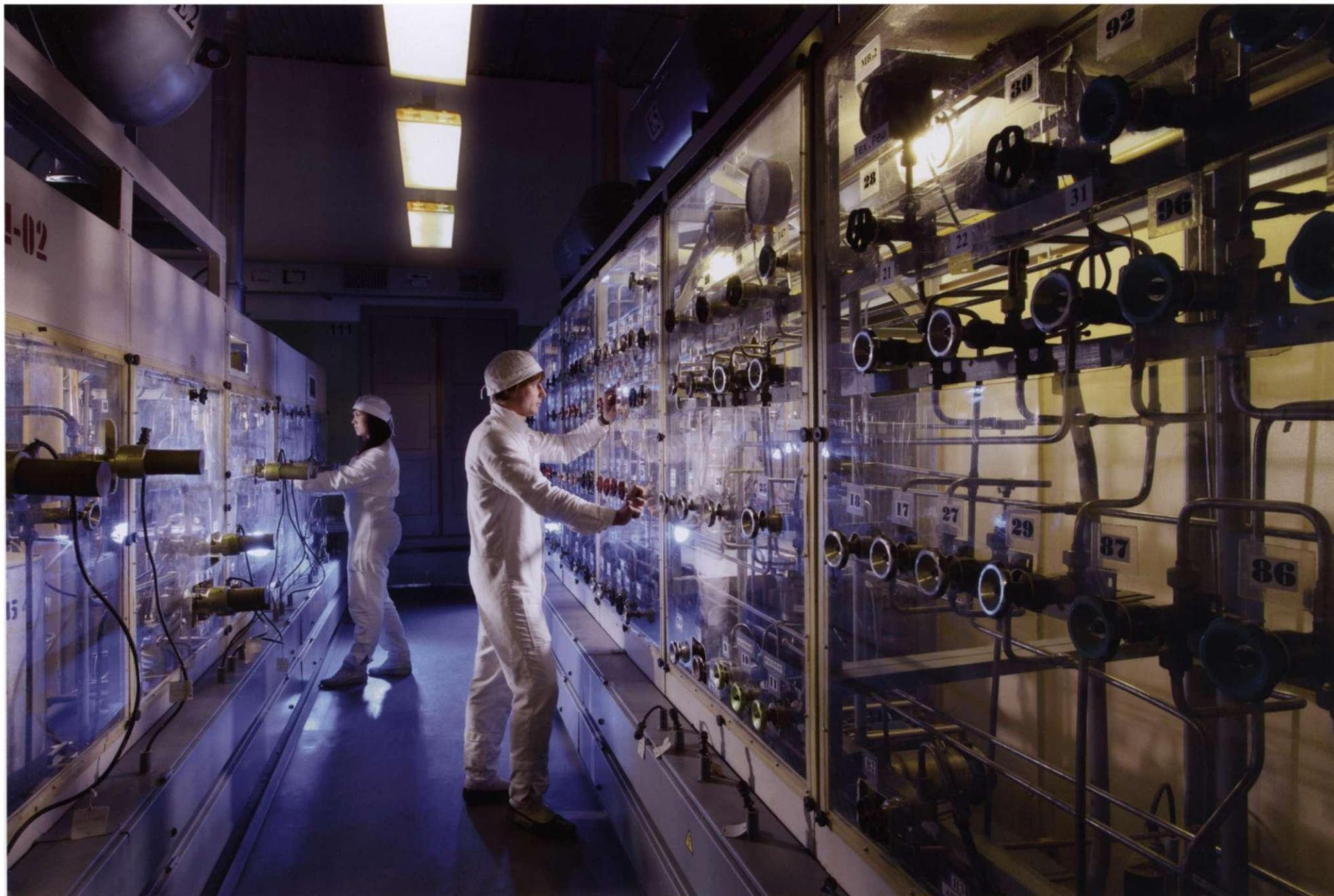
Установка компримирования. Наполнение баллонов высокого давления гелием.
