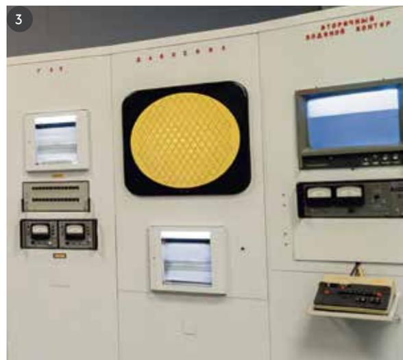
3 Табло световой сигнализации давления газа в ячейках графитовой кладки реактора
