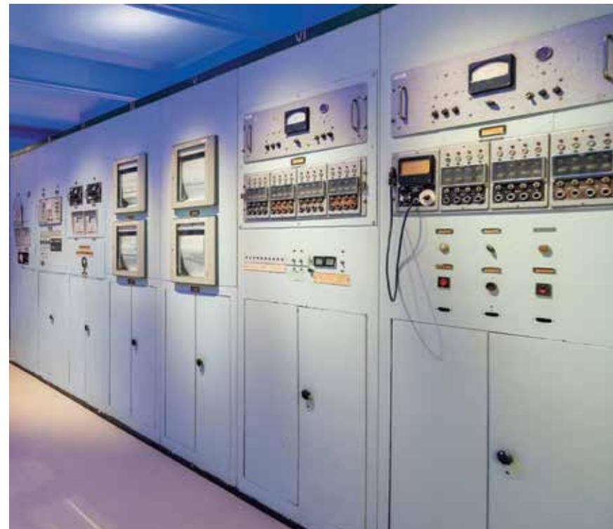
Щит «И». Приборы контроля гамма-излучения в помещениях станции
