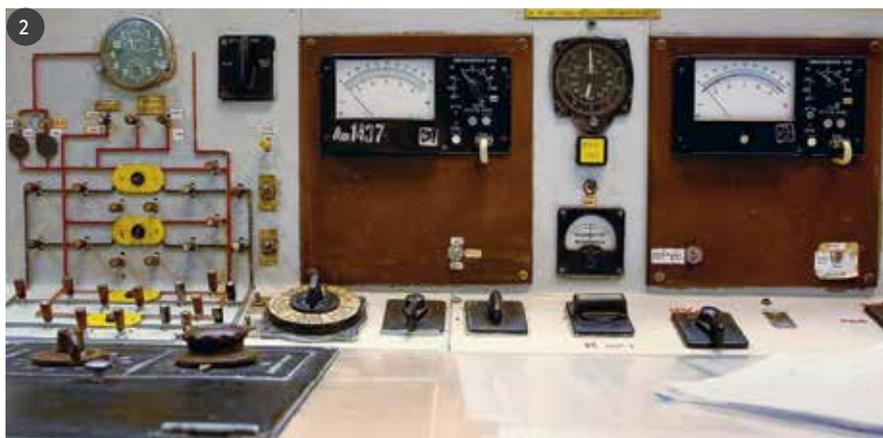
6 Фрагмент щита управления. Амперметры контроля нагрузки насосов ГЦН, ВЦН
