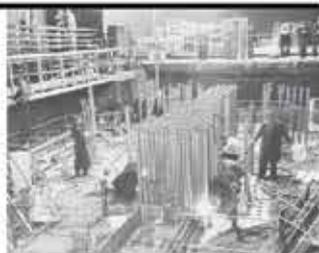
Монтаж стальной оболочки реакторной установки. Энергоблок АЭС-200. Энергоблок № 2. Белоярская АЭС. 1960-е
