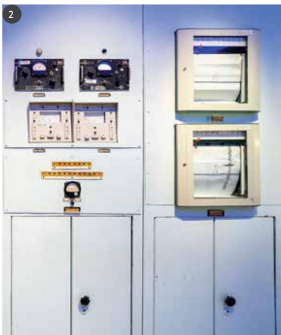
2 Щит «И». Приборы контроля гамма-излучения в помещениях станции и 2 самопишущих электронных потенциометра
