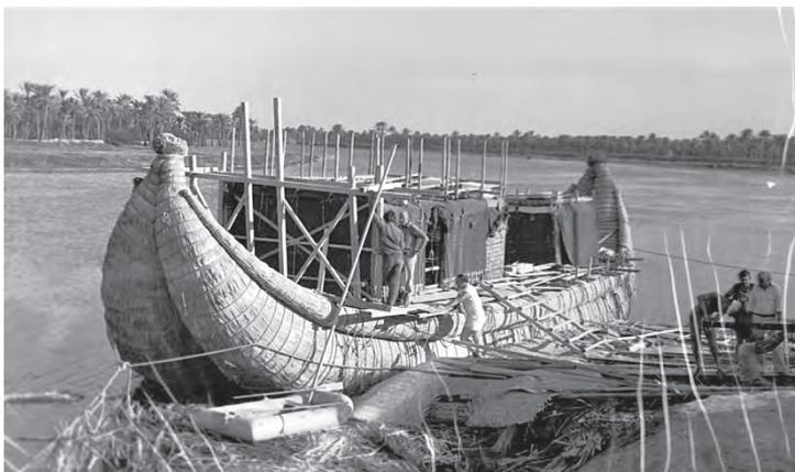
*Строящееся «плавсредство» «Тигрис» Тура Хейердала на стапеле в Басре.
