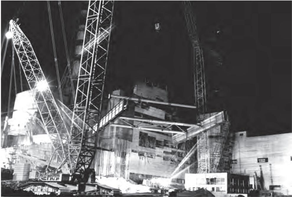
*«Демаги» в работе. Монтаж балок Б-2 перекрытия на четвертом блоке ЧАЭС. 1986 г.*
