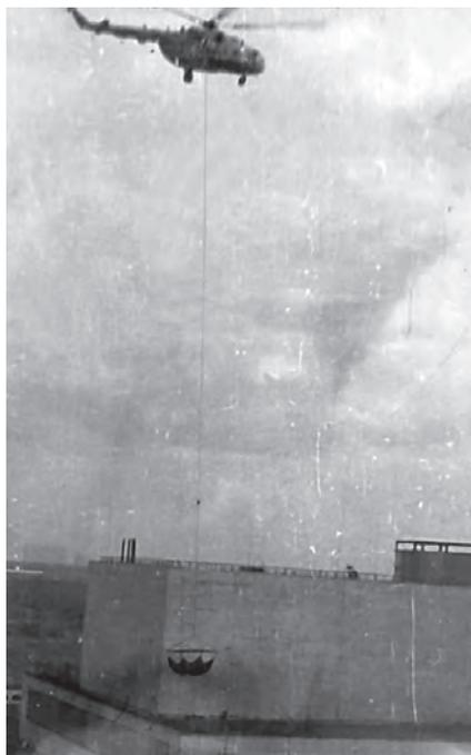
*Очистка кровли от радиоактивных обломков клеевыми захватами с использованием вертолетов. Июль 1986 г.*
