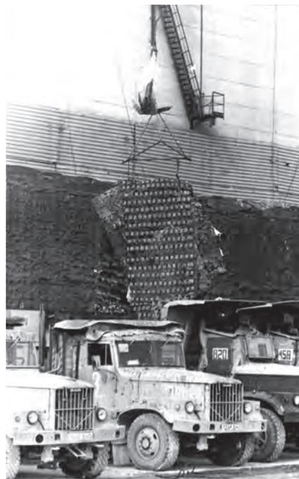
*Разборка кровли на машзале 4-го блока с использованием клеевых захватов и кранов Демаг. 1987 г.*
