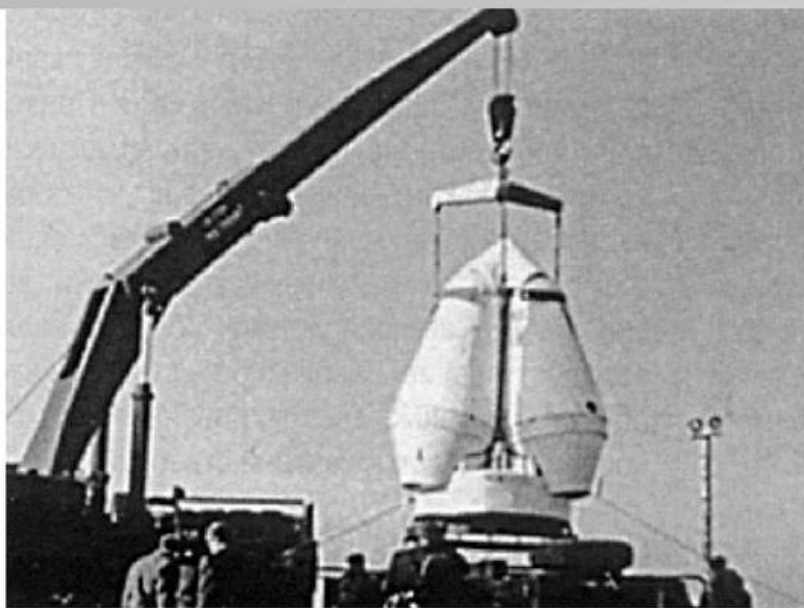
Монтаж макета головной части из трех боевых блоков с установленной в шахтной пусковой установке МБР Р-36П
