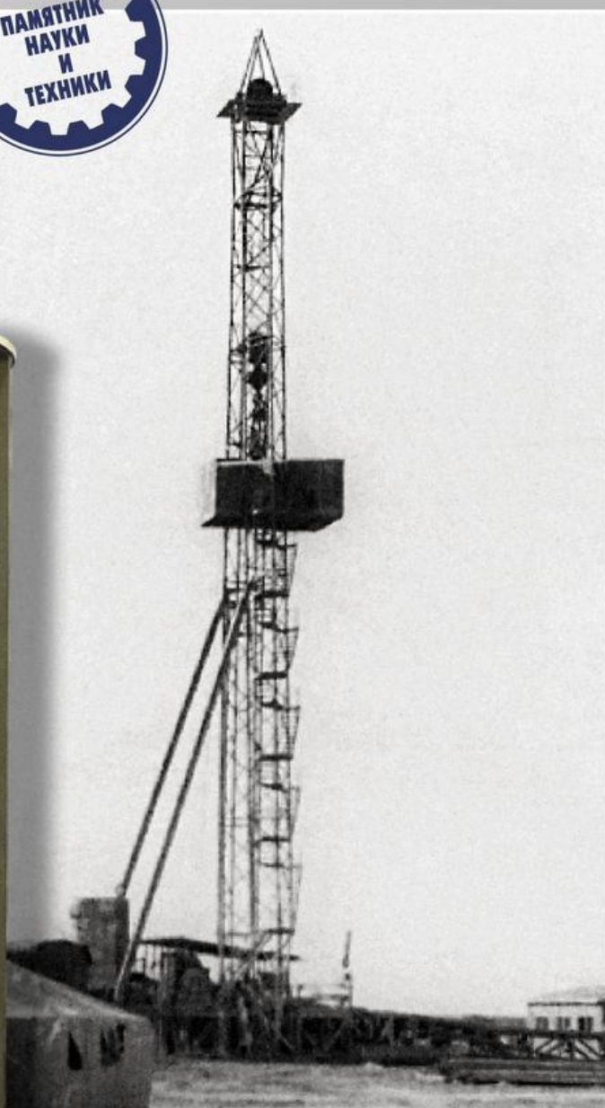
Вышка бурения вертикальных скважин для подземных ядерных испытаний
