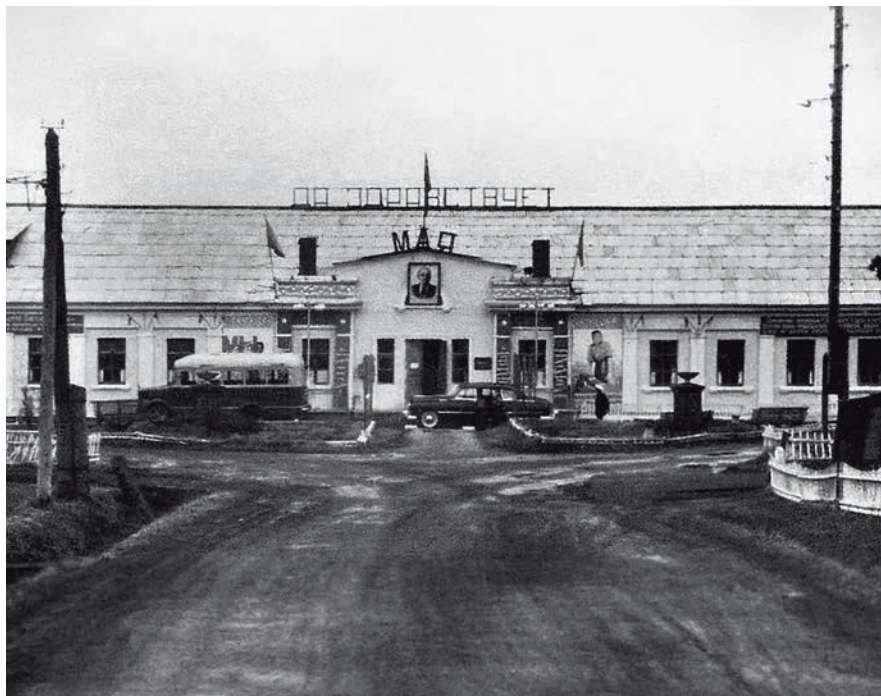
Здание Управления строительства. 1953–1955 гг.
