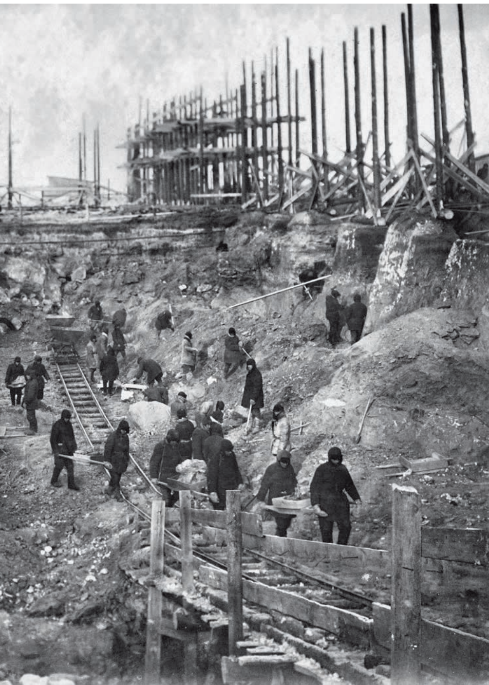
На строительстве котлована для первого промышленного уран-графитового реактора. 1946–1947 гг.
