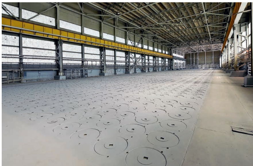
Хранилище остеклованных отходов
