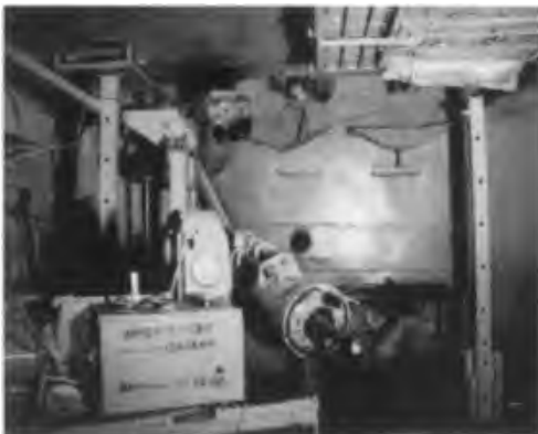
Рис. 2.5. Превентор (вход) скважины в пом. 515/3. Скважина пробурена в шахту реактора
