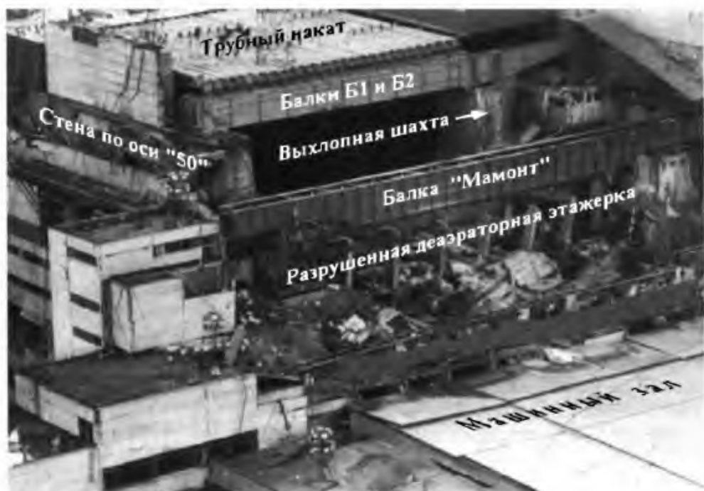
Рис. 1.17. Балки и конструкции объекта «Укрытие»
