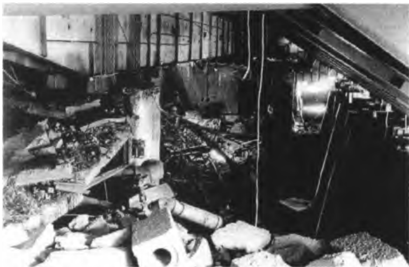
Рис. 3.19. Зона образования и подъема пыли при гипотетическом падении северной части кровли «Укрытия» (северных клюшек)
