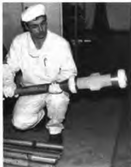
Рис. 2.10. Подготовка к работе теплотрического зонда для измерений в скважинах.
