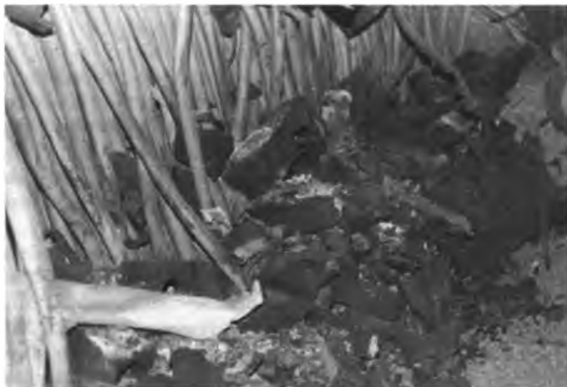
Рис. 3.21. Фото южного квадранта пом. 305/2. Под смятыми трубами нижних водяных коммуникаций обгоревшие графитовые блоки, пол залит бетоном
