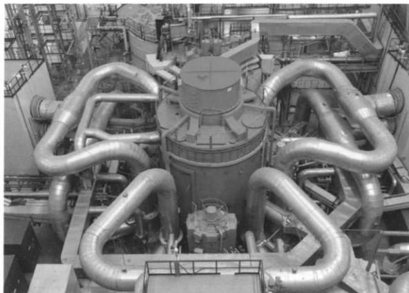
**Энергоблок** состоит из реакторной установки с реактором типа БН-800, турбины К800-130/3000 и турбогенератора ТЗВ-890-2У3 мощностью 890 МВт, напряжением 24 кВ, с бесщеточной системой возбуждения, с полным водяным охлаждением.
