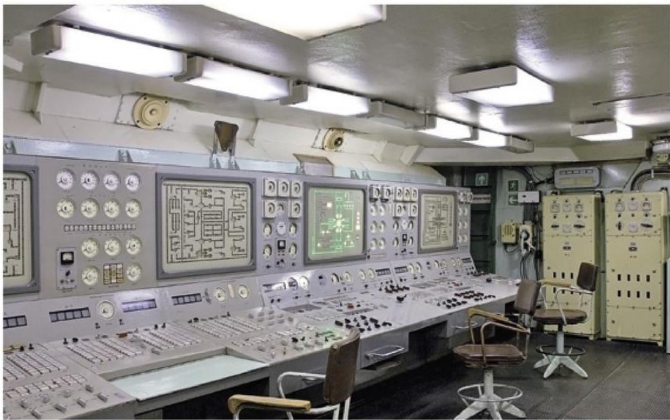
Пульты управления реакторами атомной паропроизводящей установки ОК-900
