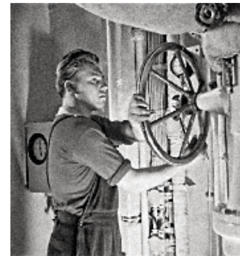
Регулировка подачи пара на главные турбогенераторы. 1960-е гг.
