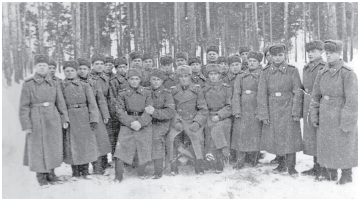
Военные строители в/ч 01060. Г. Лесной.
