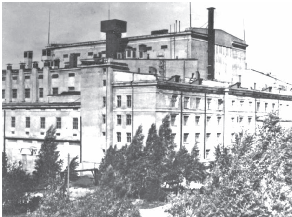
Здание Первого цеха завода № 814.
