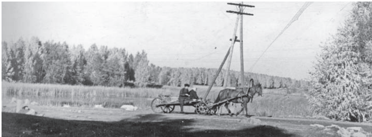
Грунтовая дорога в окрестностях г. Озерска.
