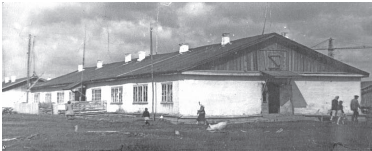
Барак. Жилище первых строителей. Г. Свердловск-45.
