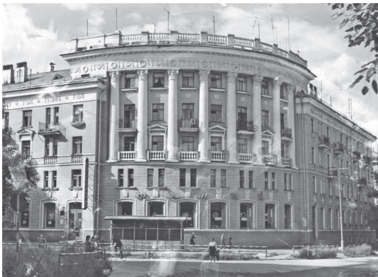
Здание постройки 1950-х гг.
