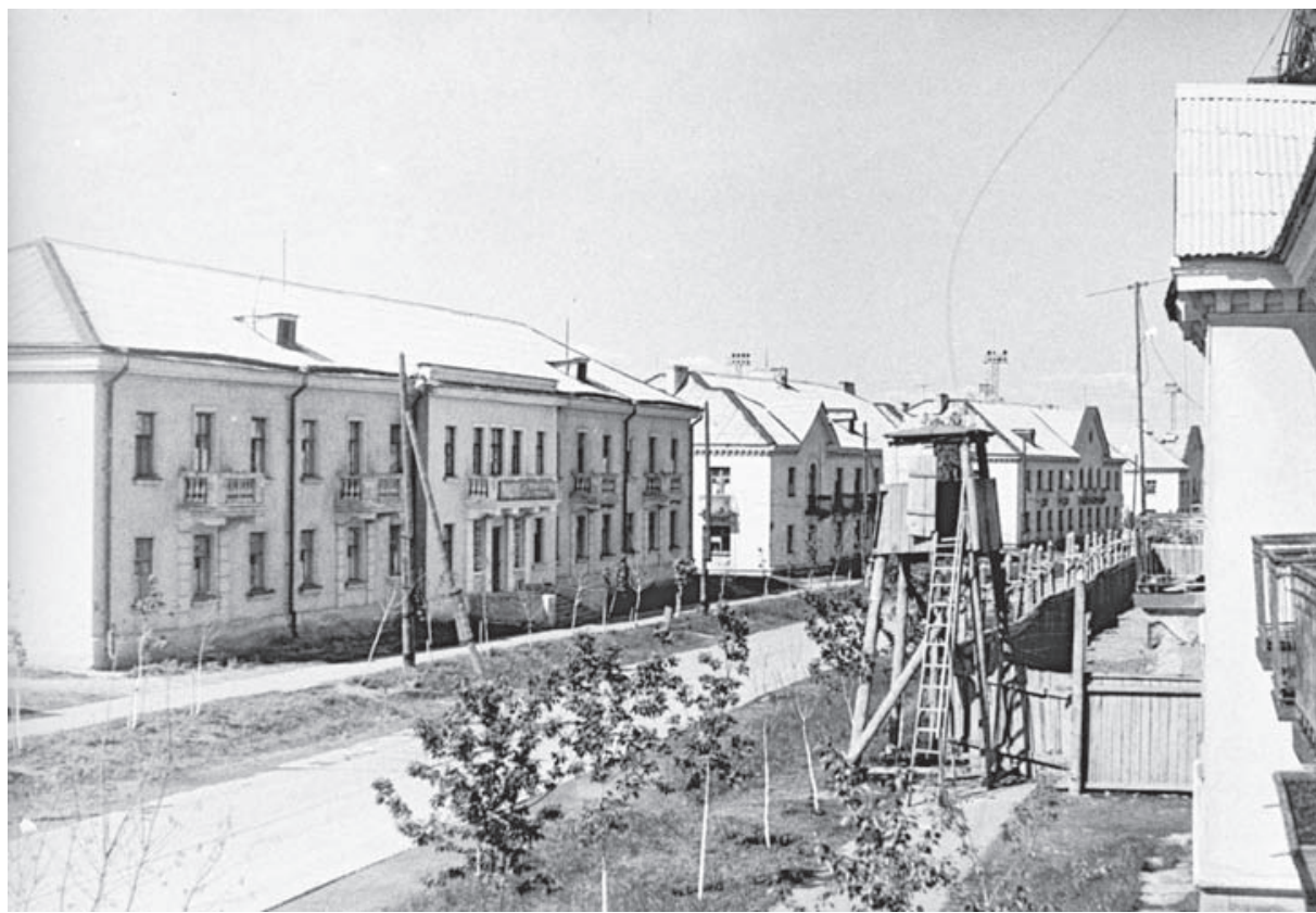
Зона. Строится молочная кухня (слева). Г. Озерск, ул. Кирова д. 8. Фото В.Г.Сергеева.
