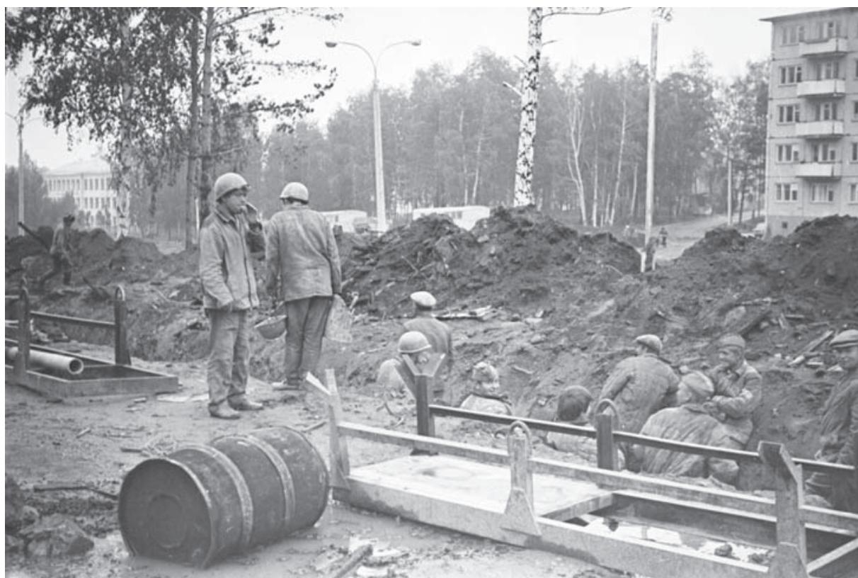
Строится дом по ул. Семенова 10. Г. Озерск. Фото Г.А.Золотарёва.
