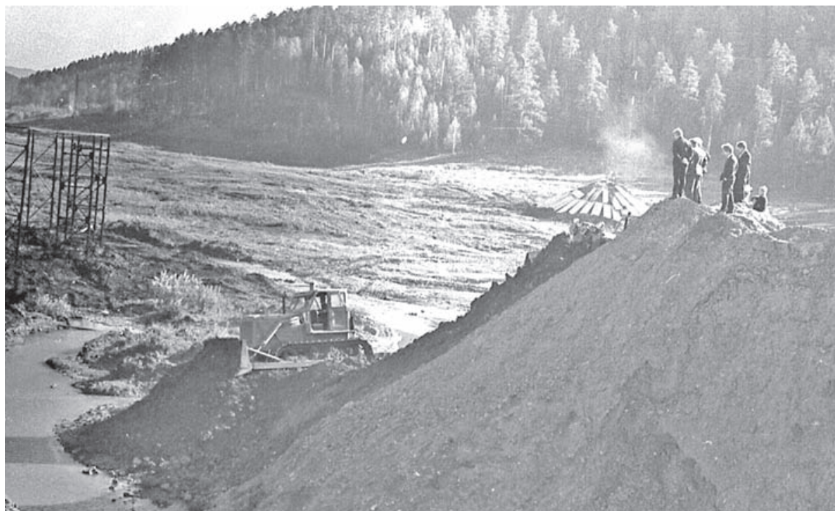
Строительство плотины пруда Смольный. Г. Трехгорный.
