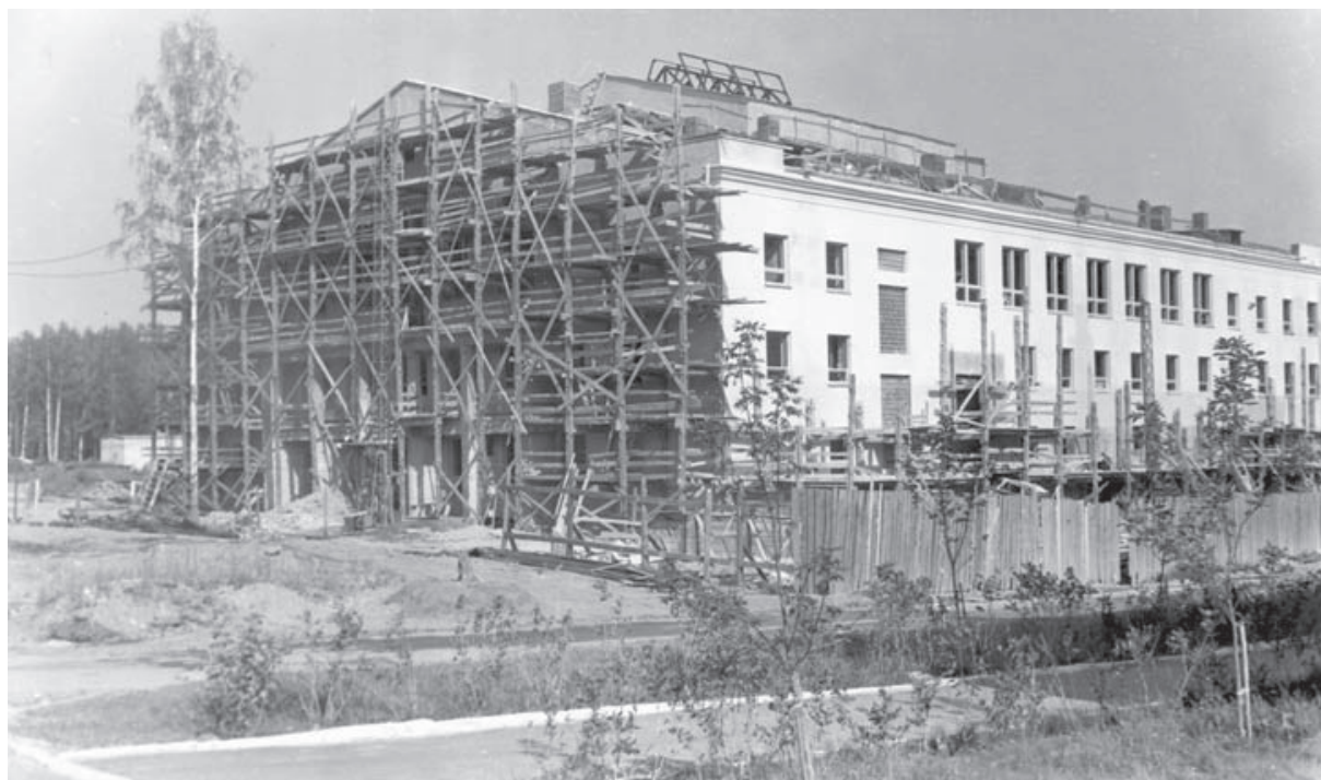
Строительство Дома культуры.
