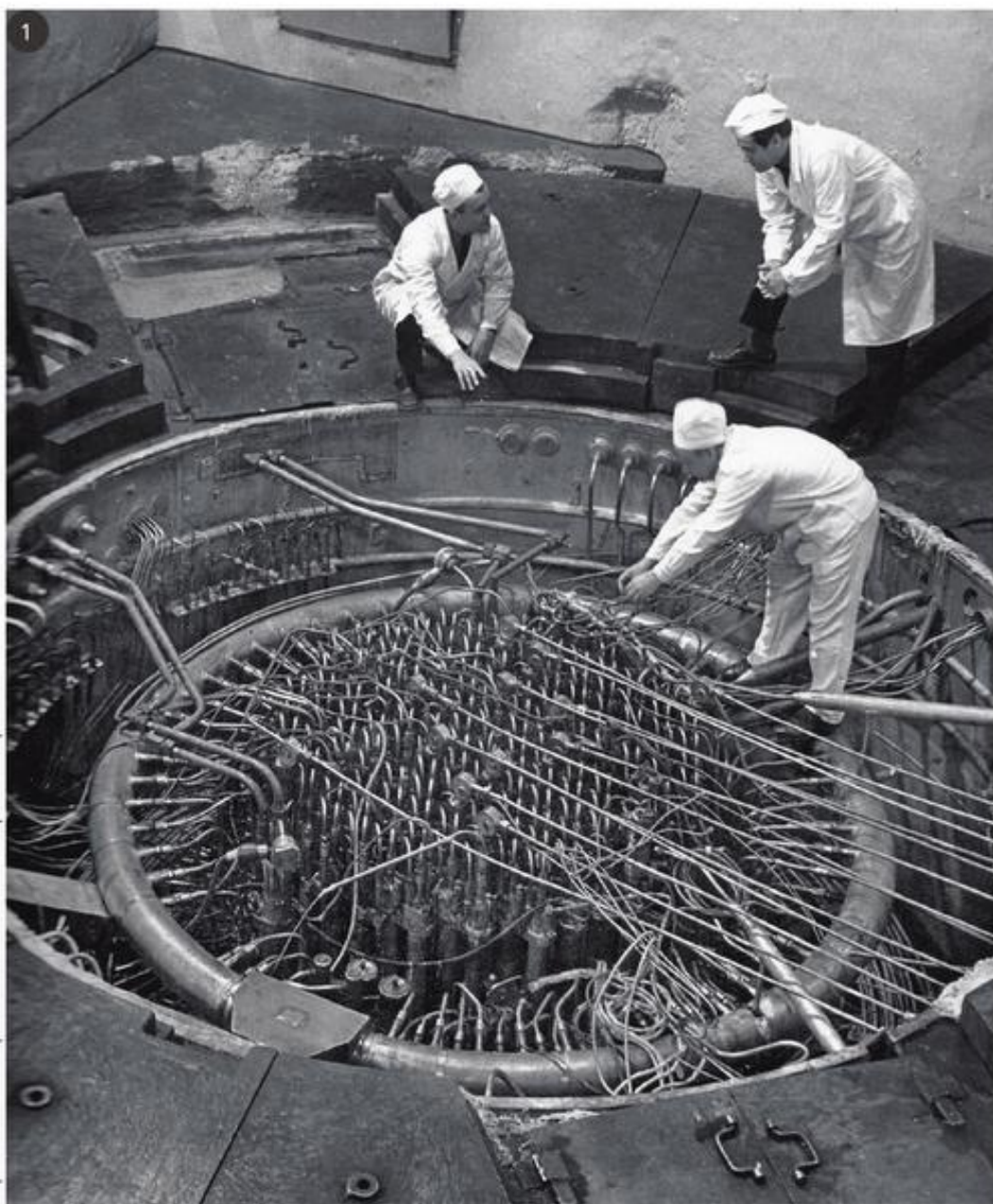
1 Проведение регламентных работ под крышкой реактора. Обнинск, АЭС № 1. 1950-е гг.
