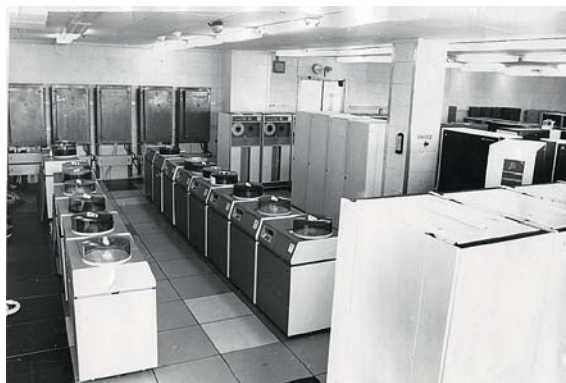
Фото фрагмента ИВК АНИС-В2 в зд. 103 с дисками общей ёмкостью 435 Мб
