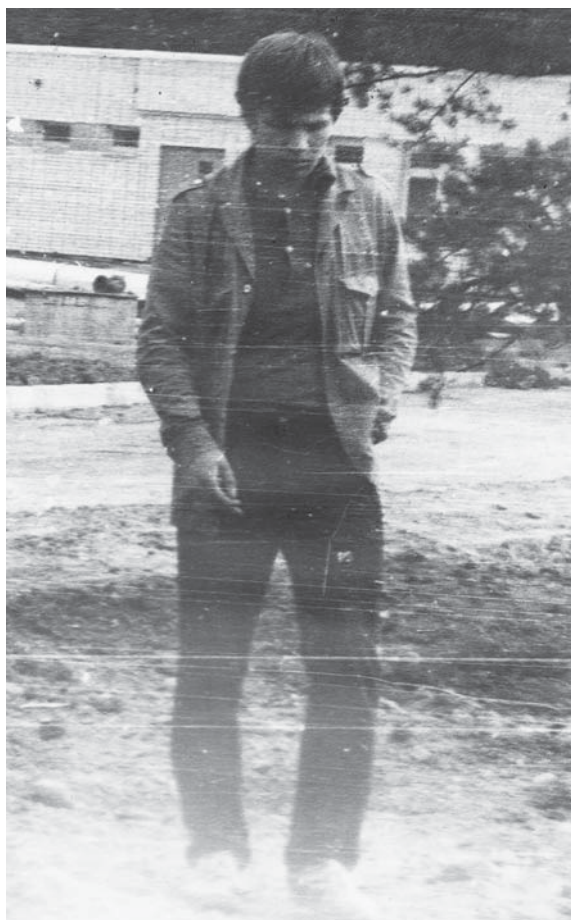
О.Ю. Пыхтеев на стройке
