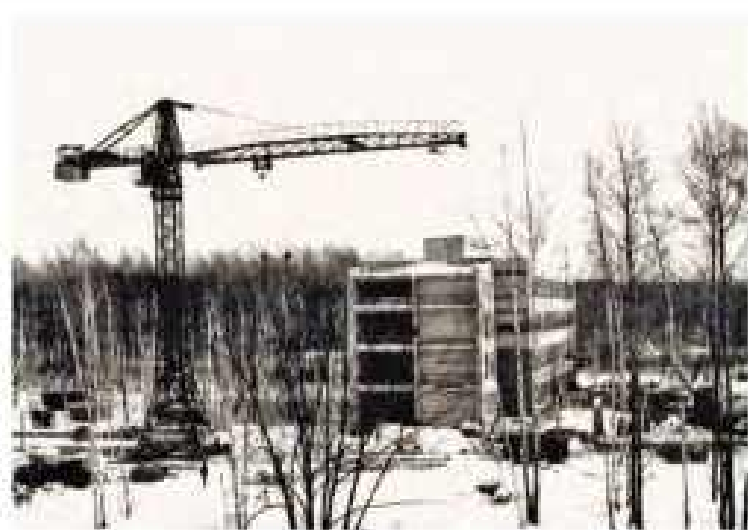
Строительство комплекса ЦИПК
