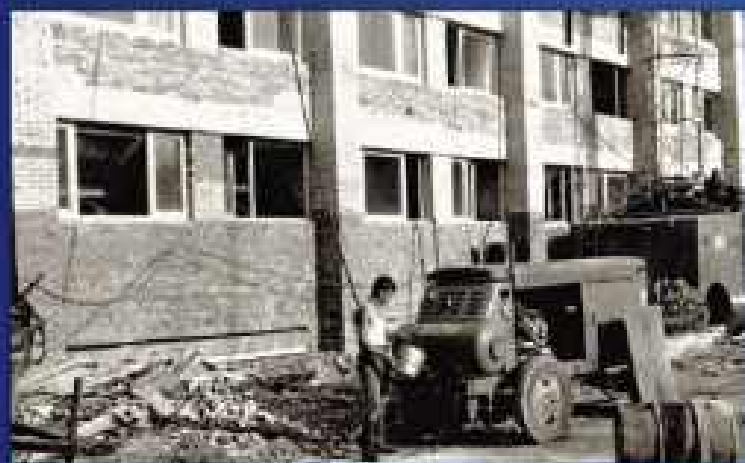
Строительство гостиницы ЦИПК
