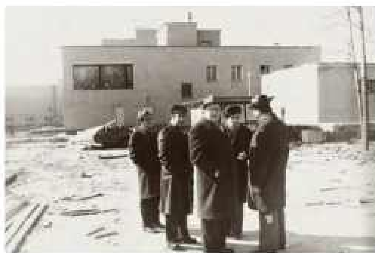
Осмотр хода строительства отраслевой выставки
