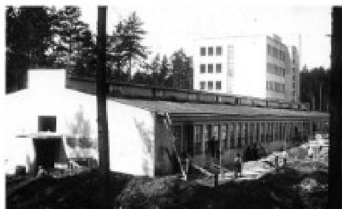
Строительство Уральского физико-технического института в Свердловске, 1935 г.
