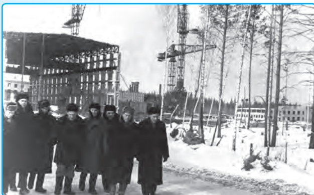
Изучаем строительные конструкции Белоярской АЭС, февраль 1960 года.
