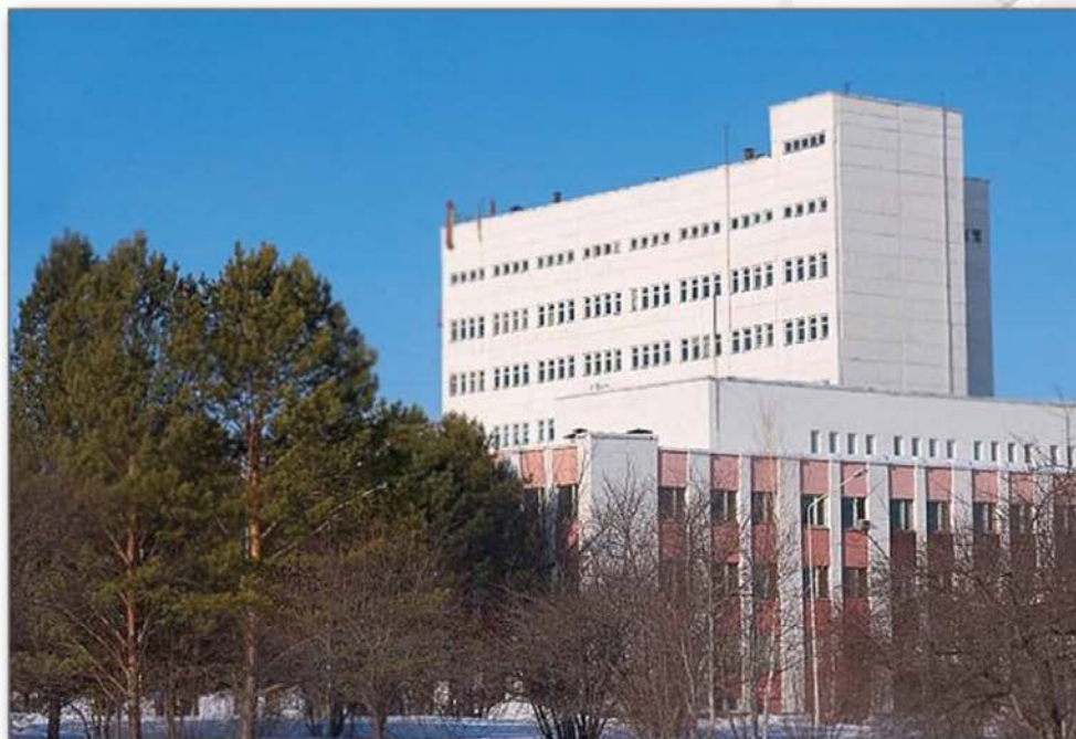
Самое высокое здание на промышленной площадке ОАО «ПО ЭХЗ» – цех стабильных изотопов, построенный по проекту «Светлана»
