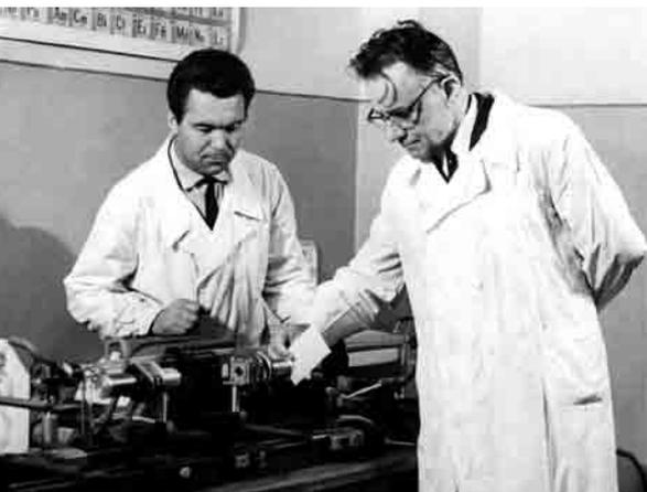
В.Ф. Плохих и М.М. Носков у самодельного газового лазера на углекислом газе, 1968 г.
