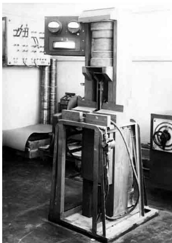
Аппарат для контроля корпусов артиллерийских снарядов, 1943 г.
