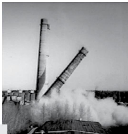
■ Мирный взрыв: обрушение трубы выбросов очищенных технологических газов химзавода. По мере эксплуатации трубы корродируют, разрушаются и возникает необходимость их замены. Замена производилась путем направленного взрыва и строительством на этом месте новых труб.
